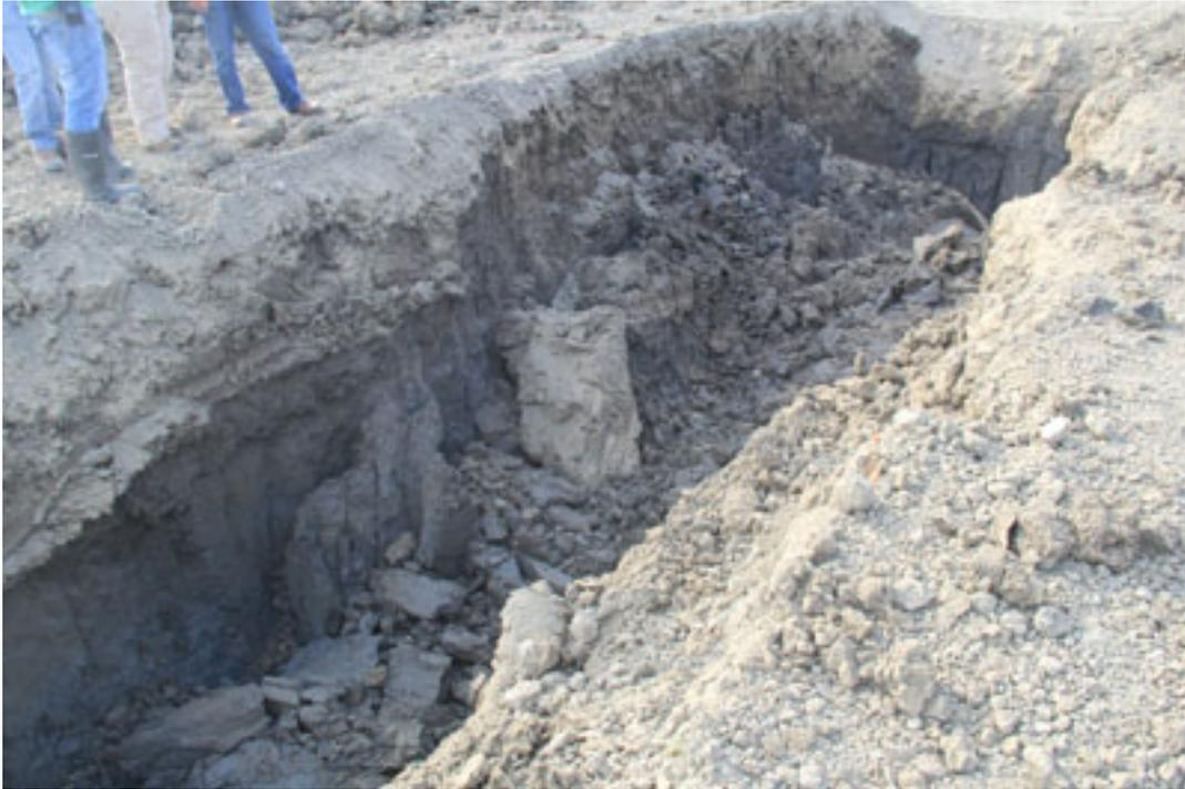
Fig. 8 Fotografia de trincheira após colapso
