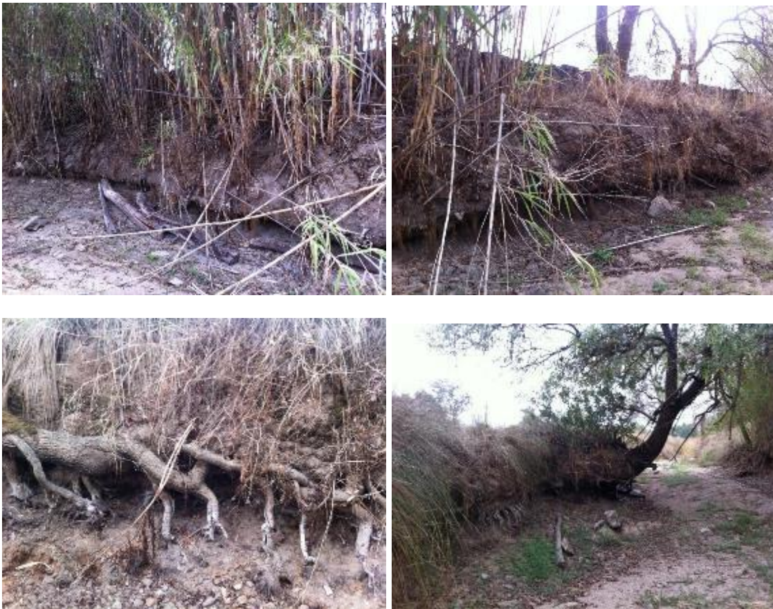
Figura 21 – Instabilidade das margens.
