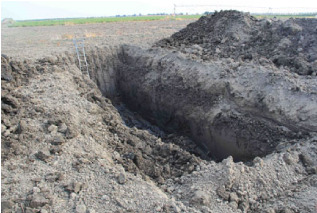
Figura 8- Fotografia de trincheira antes de colapsar
